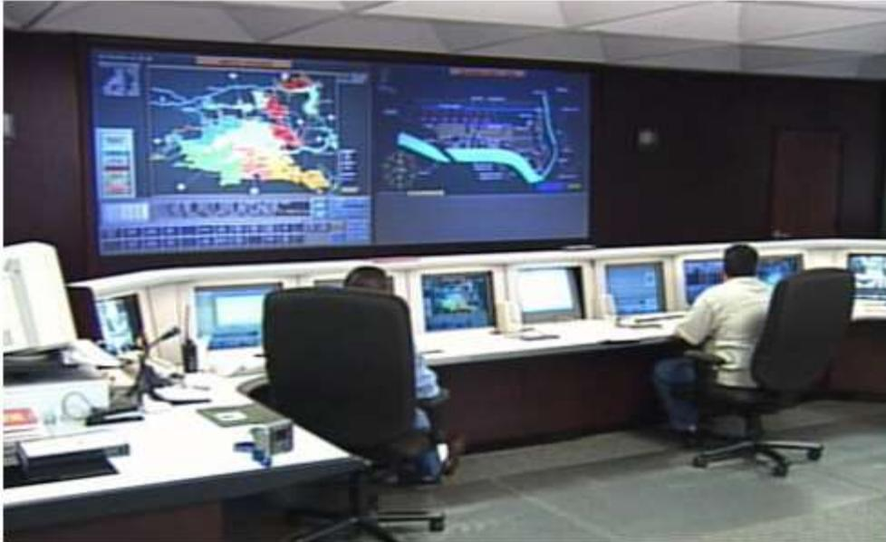
Gambar 7.4 Sebuah *Master Control Room* untuk mengontrol Sistem Proses Jarak Jauh
